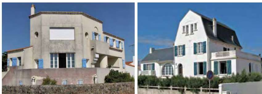
Maisons balnéaires, avenue de la corniche (source : L'architecture balnéaire en Vendée, CAUE85 )
